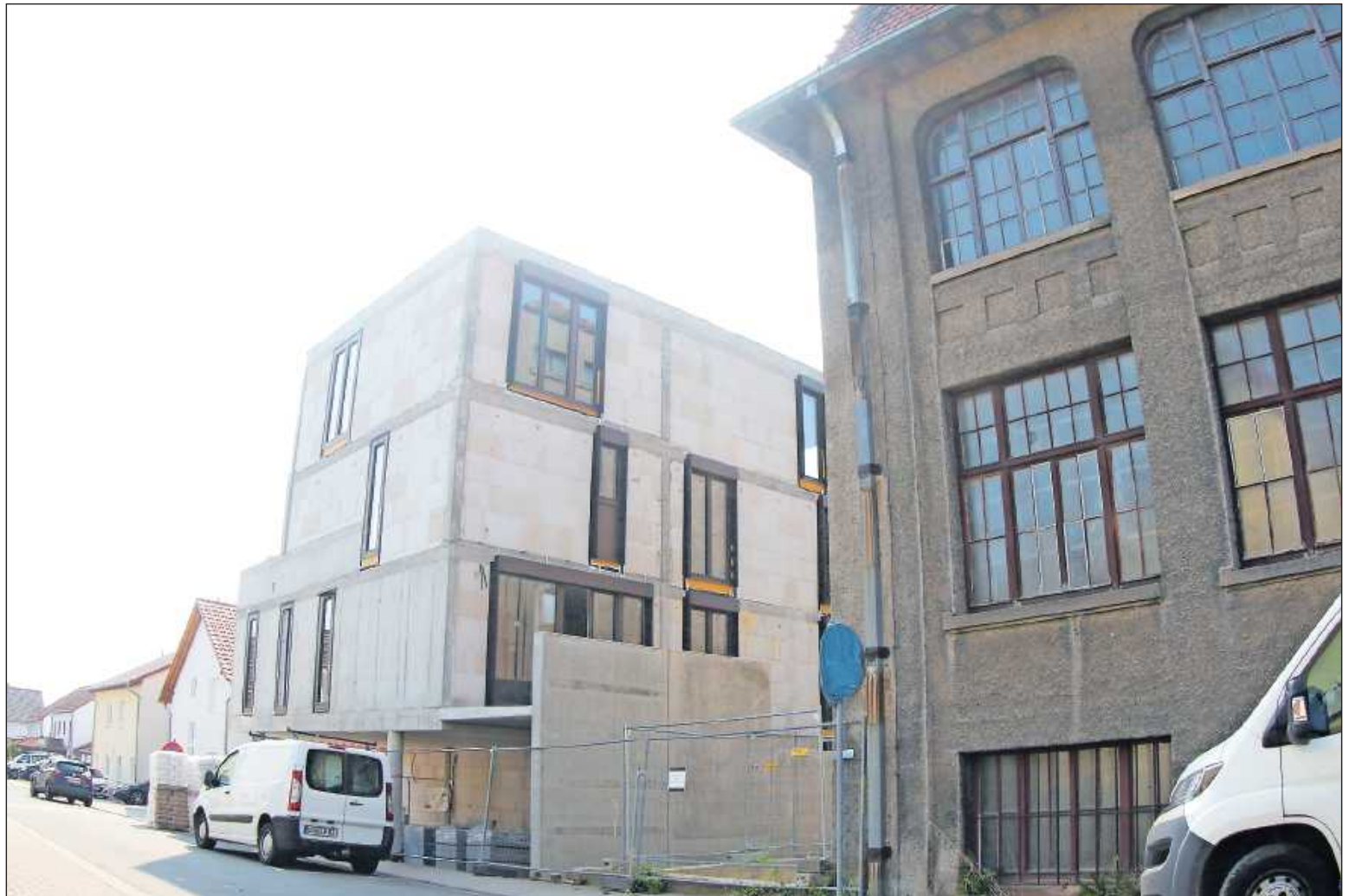
Als Negativbeispiel bezeichnen die Anwohner des CSR-Geländes die Bauten auf dem Areal der ehemaligen Gesangbuchfabrik.
